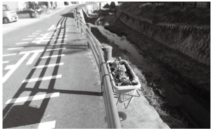
中町地区植栽状況
