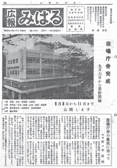
● 昭和40年9月1日 第222号 三春町役場新庁舎完成
