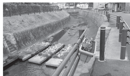
中町地区植栽状況
