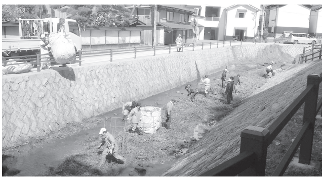
トラック・クレーンとフレコンバックを使用しての搬出状況
