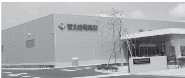
完成した東北住電精密株式会社のTEC棟
