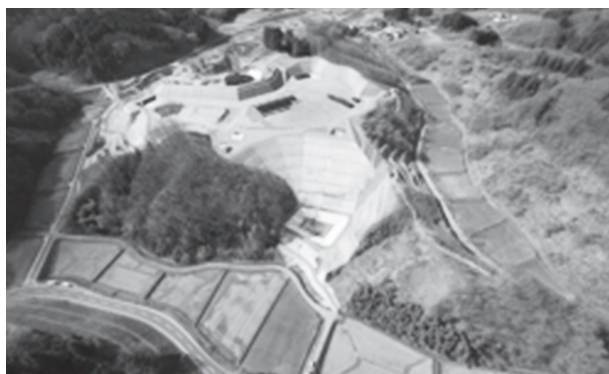
北部三地区仮置場
