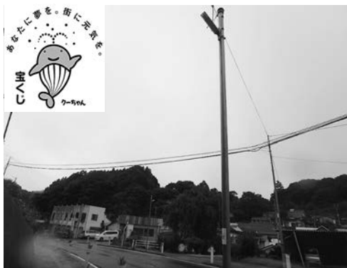
整備をしたLED防犯灯
